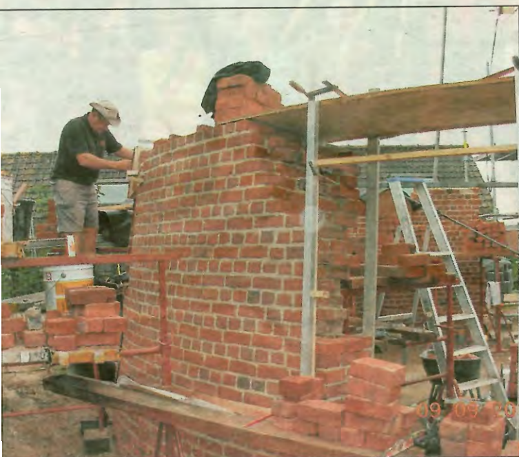
Bij de metselwerken kunnen er geen touwen worden gespannen omdat de vorm rond is. Dat maakte de opdracht extra moeilijk. (GF)
