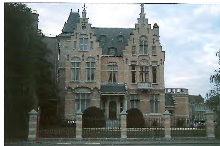
Bij de renovatie van het kasteel Bekaert te Zwevegem werd aan blauwsteenreiniging, witsteenreiniging en hydrofuge gedaan
