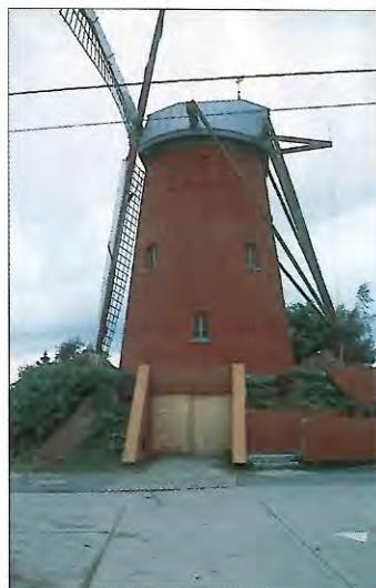
Eerst werd het voegwerk uitgediept, stenen vervangen en hermetst, vervolgens werd alles hervoeegd waarna een laag cementkalei werd aangebracht
